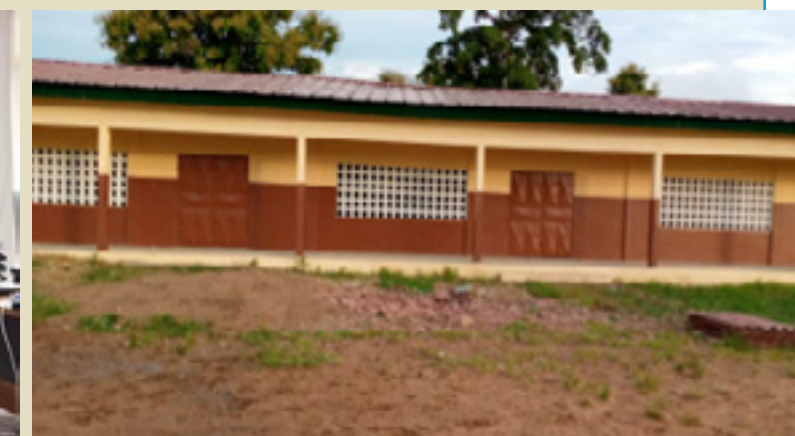
Façade d'un bâtiment de 3 salles de classe réhabilité.
