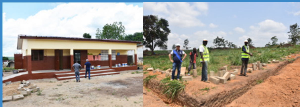
Quelques photos de suivi-évaluation des travaux au Lycée Moderne de Godiabrè à Gagnoa et de la construction de la maternelle à Ono (S/P de Bonoua).
