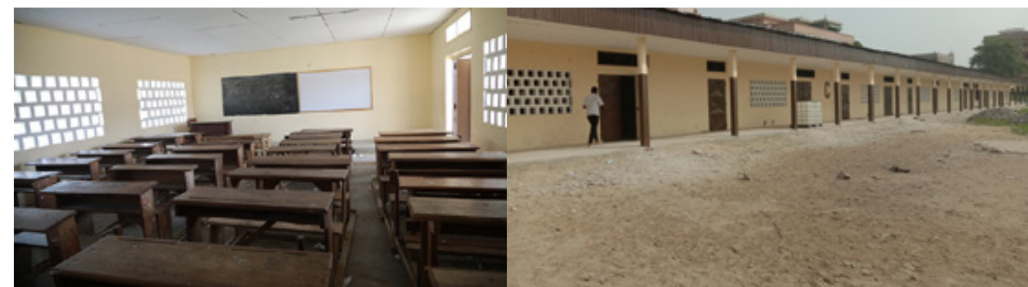
Intérieur d'une salle de classe et la façade d'un bâtiment réhabilité au Lycée Amagou Victor de Marcory
