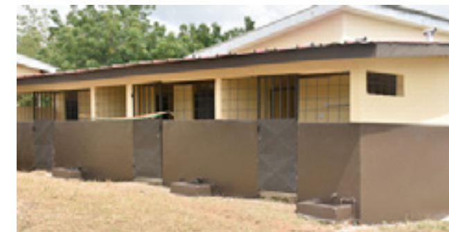
Façade d'un bloc de 6 toilettes réhabilité par la Fatom au groupe scolaire Moronou.
