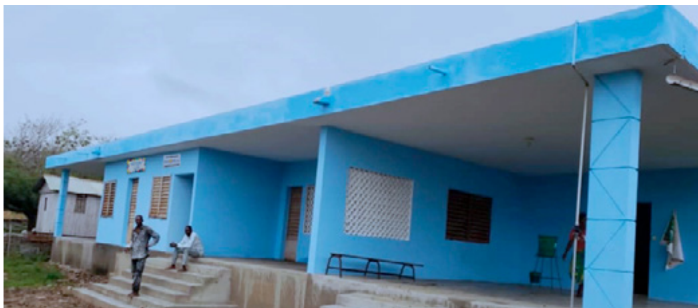
Façade du centre de Santé de HÈTIN SOTA
