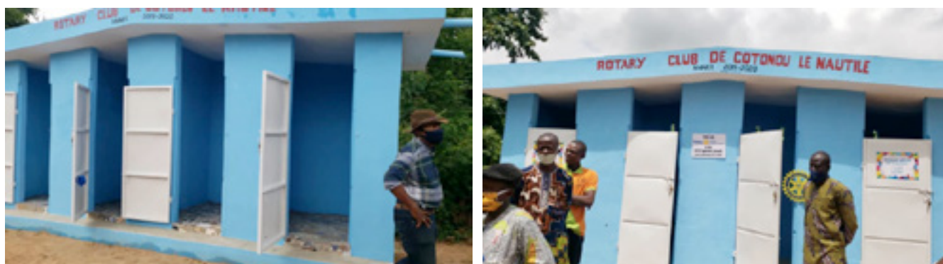
4 douches et 2 blocs de 4 latrines construits par la Fatom
